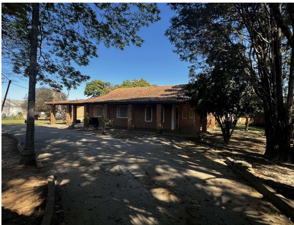
ASPECTOS GERAIS IMÓVEL
