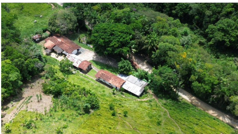
Construções civis do imóvel
