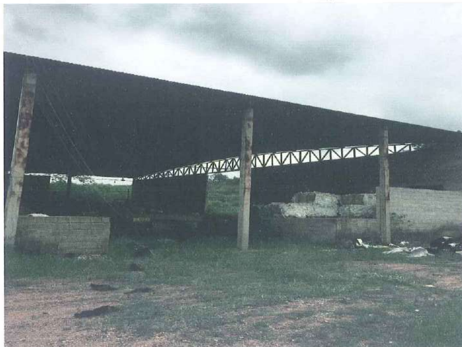
Vista geral externa do estado regular de conservação do galpão.
