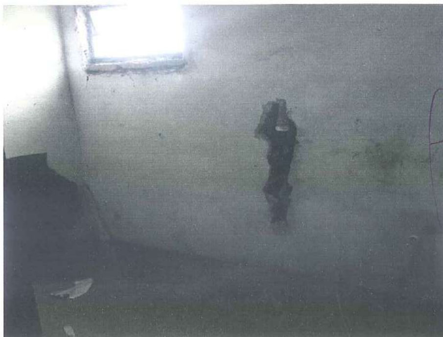
Vista geral interna de um dos banheiros inacabados.
