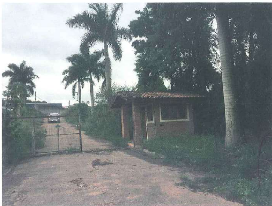
Demonstração geral ao acesso à área do Galpão, com numeração frontal nº 1.030, Sítio Água Branca, Bairro dos Leitões, Jundiaí – SP.
