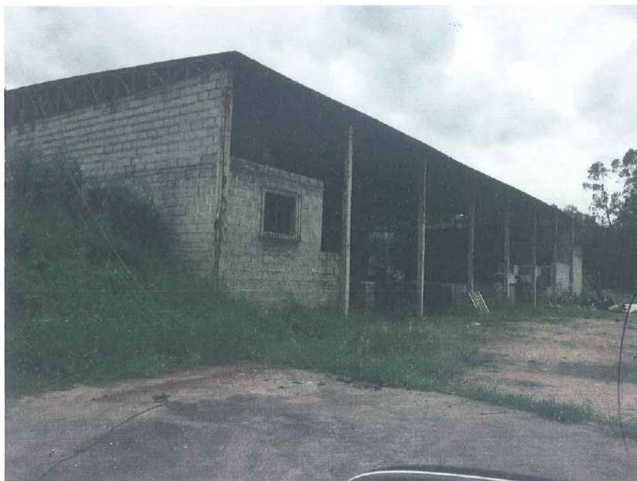
Vista geral externa do galpão, sem revestimento externo.
