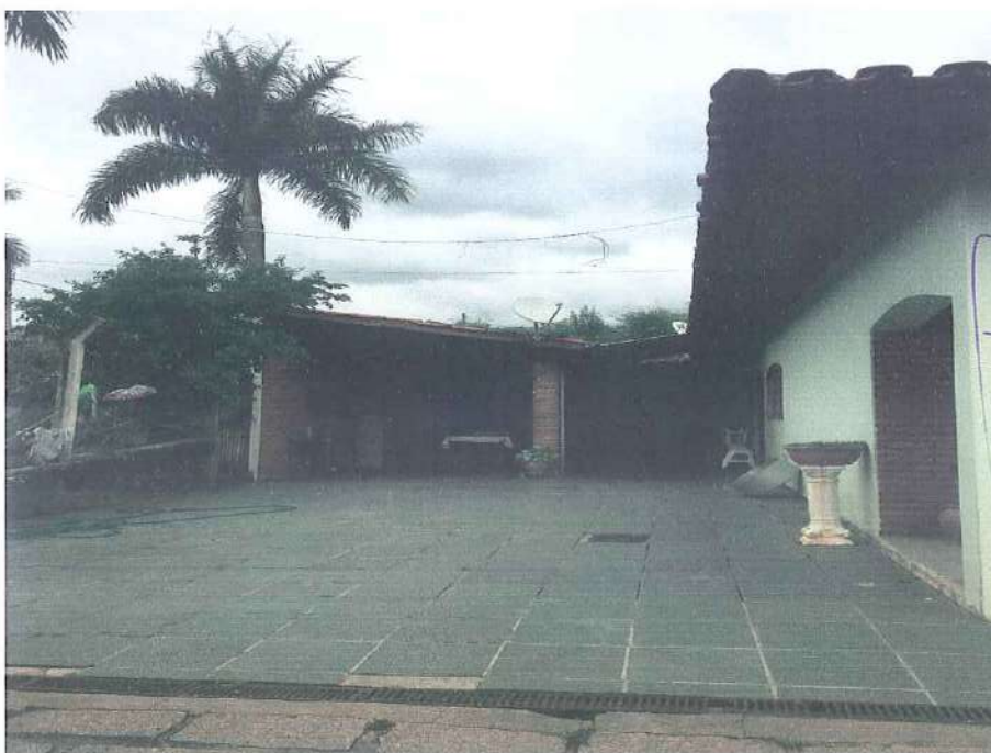
Destaque para a lateral esquerda (lavanderia e garagem).
