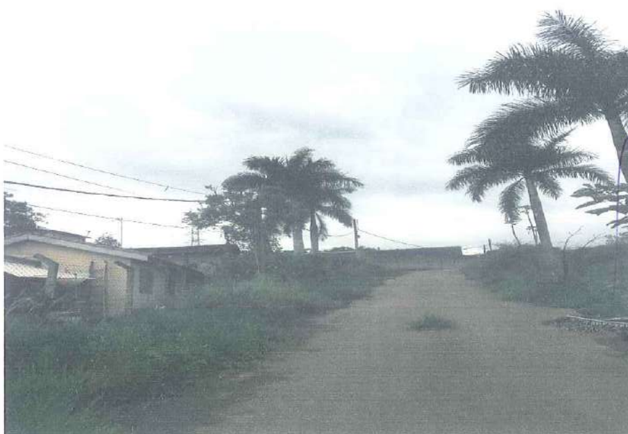
Destaque para o caminho pavimentado de veículos de acesso ao galpão.
