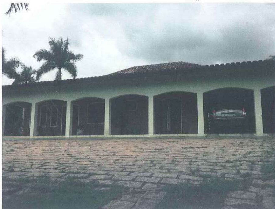
Demonstração geral frontal da casa principal.
