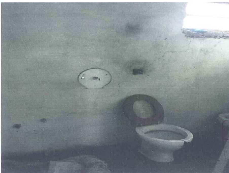
Vista interna do banheiro.
