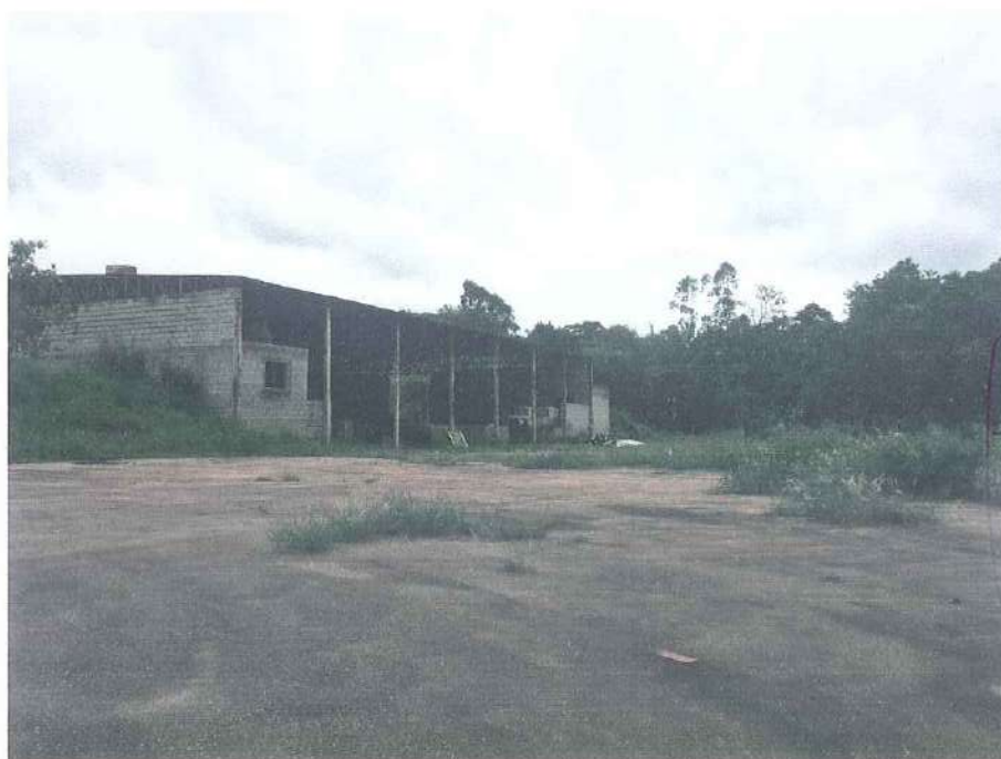
Demonstração geral do término da rampa e vista geral do galpão.
