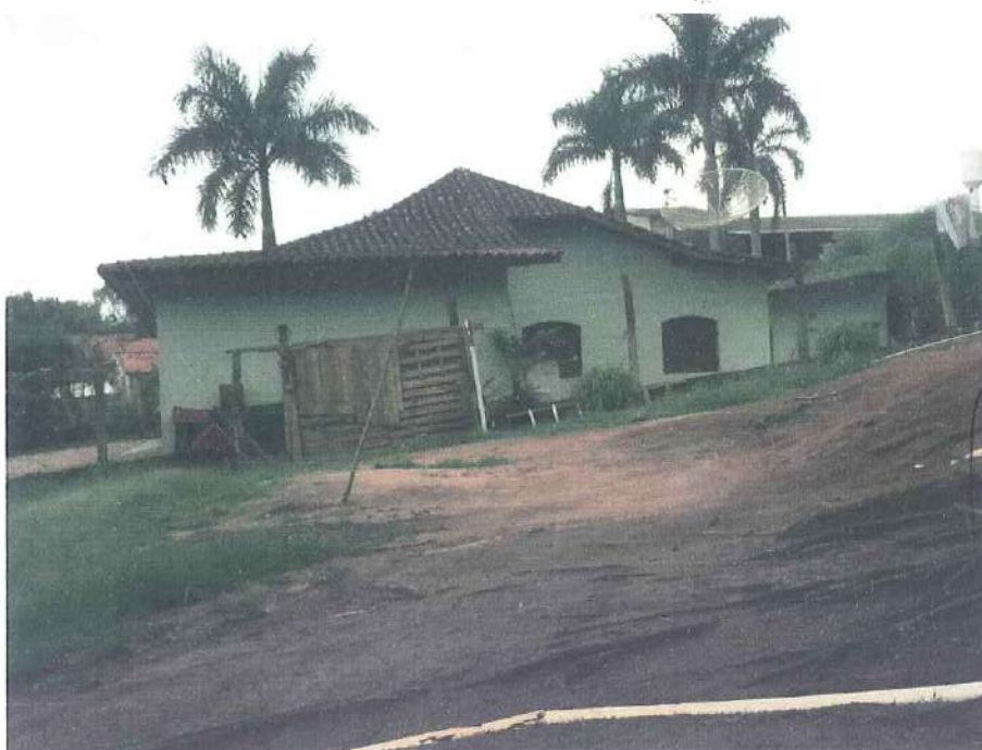
Vista da lateral direita externa da construção principal.
