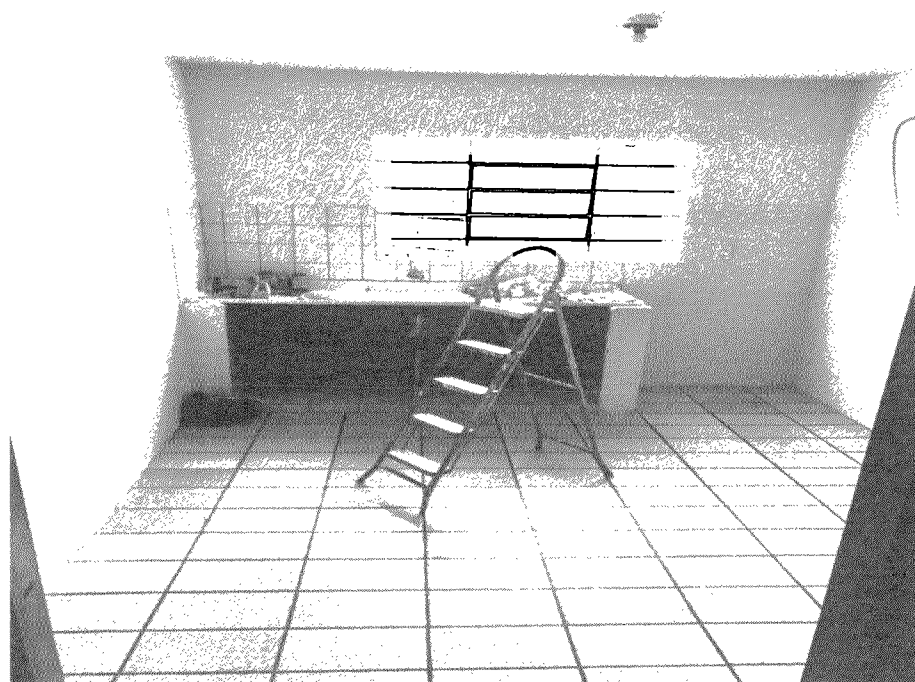
Vista do banheiro e da cozinha da edícula dos fundos.
